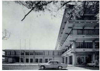
竣工当時の本庁舎
