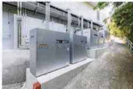
ガス変換機 (LPガスと空気を混合)
