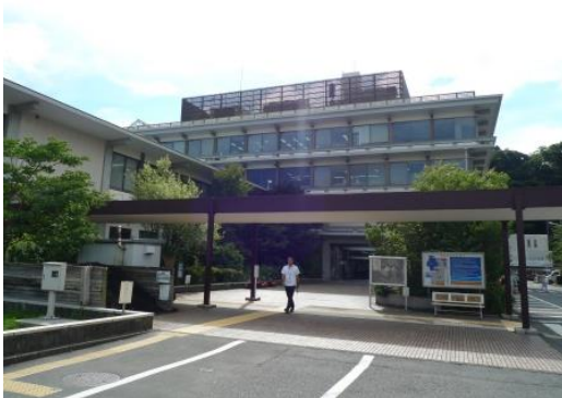
本庁舎の現況
