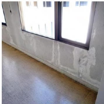
雨漏りによる壁の劣化
