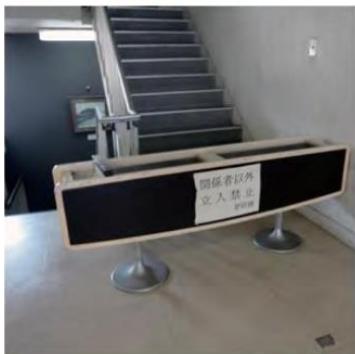
備品による立入禁止措置
