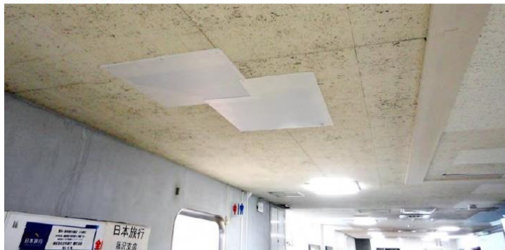
雨漏りによる壁の劣化
