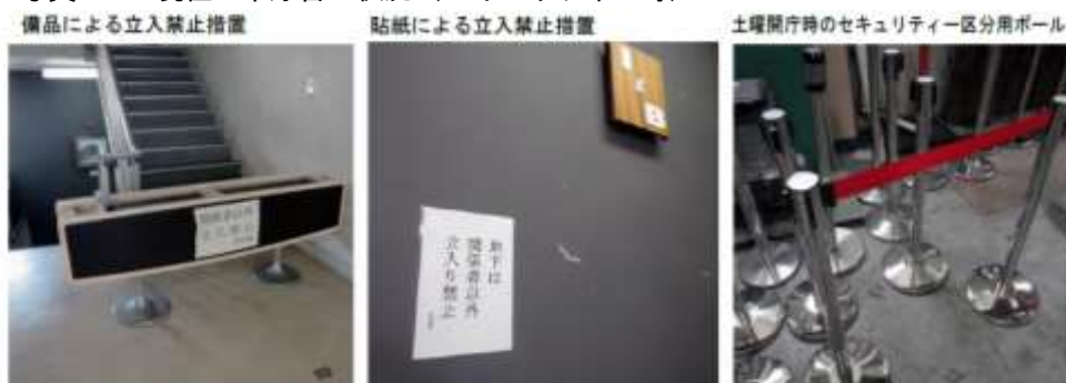
写真 1-5 現在の本庁舎の状況（セキュリティー等）
