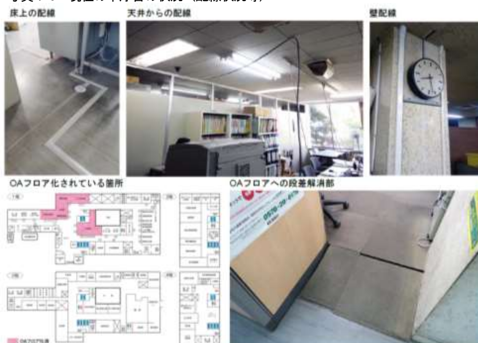
写真 1-6 現在の本庁舎の状況（配線状況等）
