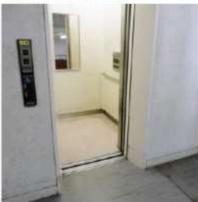
奥行きが足りないエレベーター
