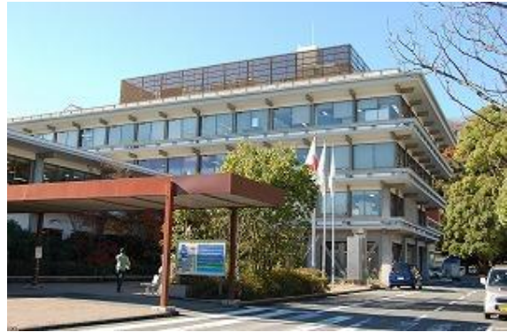
写真 0-1 市役所本庁舎
