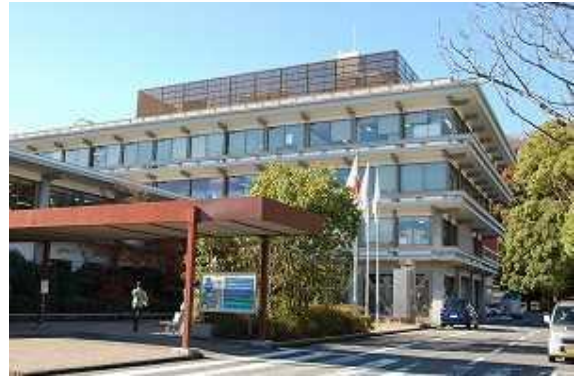
写真 0-1 市役所本庁舎
