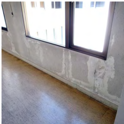
雨漏りによる壁の劣化
