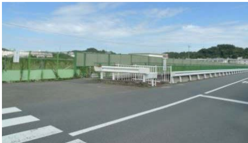
敷地南側から
