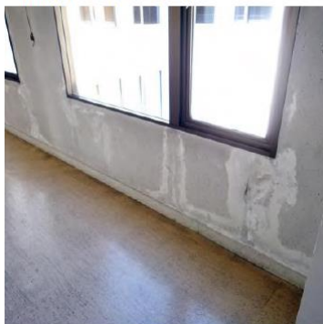
雨漏りによる壁の劣化
