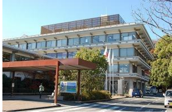
写真 市役所本庁舎
