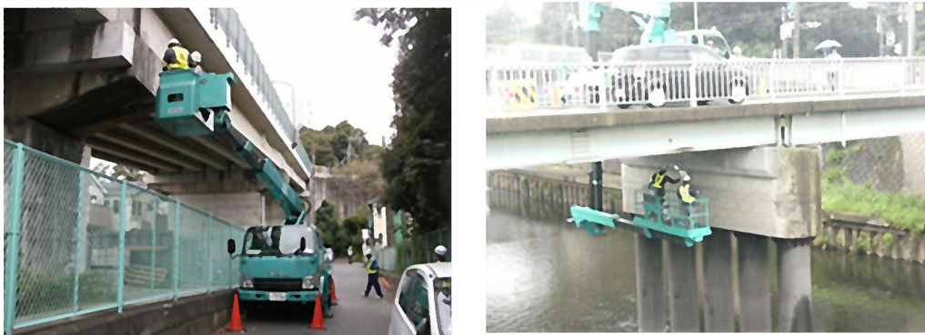
写真 6－1 橋りょう点検状況
