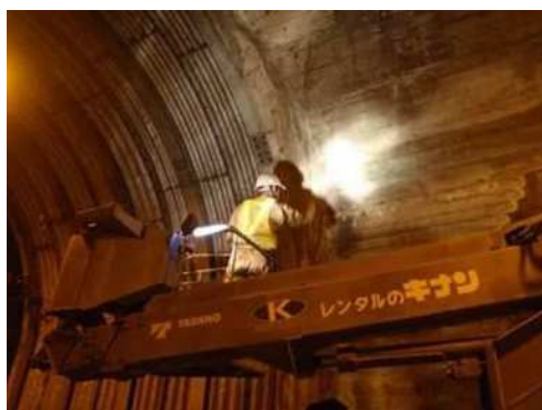
写真 4－1 道路トンネル点検状況
