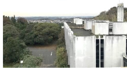
本館の屋上からの風景
