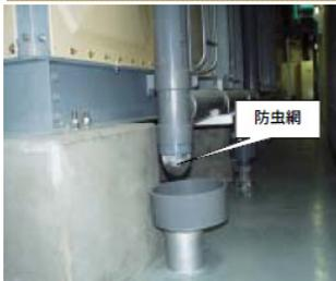
オーバーフロー管、通気管の防虫網が破損していないか確認します。防虫網が破損していると水槽内部に虫や鳥などが入り込み、飲み水が汚染されることがありますので、必ず補修しておきましょう。また、排水ドレン管と接続されたタイプのオーバーフロー管では、清掃時の排水で防虫網が破れたり、防虫網の内側に塗料や錆が溜たまって抜け落ちたりしやすいので注意が必要です。
