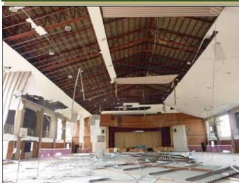
地震によって、天井材が全面的（部分的）に落下した大変危険な事例です。
