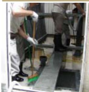
空調設備 (冷却塔等) については、レジオネラ属菌などの細菌類を増殖させないための工夫が必要です。また、冷却塔の位置が外気取入口や窓に近い場合は、飛散した冷却水のエアロゾル (細かい水滴) が空調機を介して室内に取り込まれることにより、レジオネラ症等が集団発生する可能性がありますので、エアロゾルをできるだけ飛散させないよう十分な管理が求められます。
