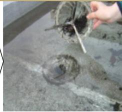
樹木の葉や枝がルーフドレインに詰まり、屋上面がプール状態となってしまう大変よくある事例です。屋上に溜まった雨水が、劣化した防水層から侵入して、天井への漏水や設備機器の漏電被害の原因になります。清掃しましょう。
