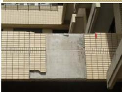
外壁タイルの一部が浮きにより、構内通路に落下した大変危険な事例です。外壁タイルが落下した付近は、通行を制限し、他に落下の恐れのあるタイルがないかどうか点検してください。また、補修を早く行いましょう。
