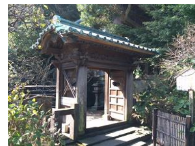
写真1-49 英勝寺 祠堂門
