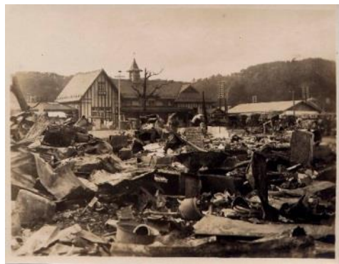
写真1-14 関東大震災の様子
