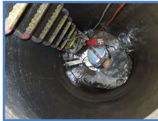
②削孔状況
