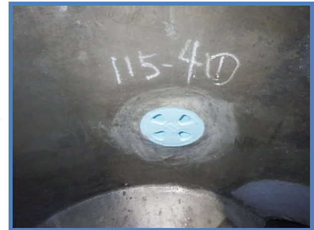
③設置完了 (消散弁設置状況)
