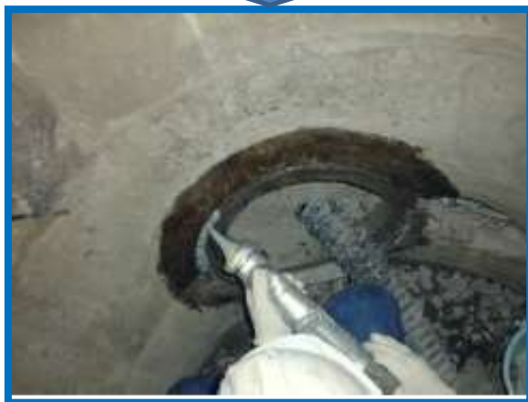
④シーリング材充填状況
