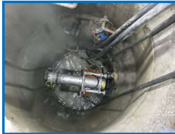
②管口切削状況
