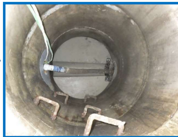
⑤インバート復旧状況
