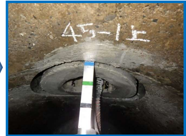
③切削状況確認
