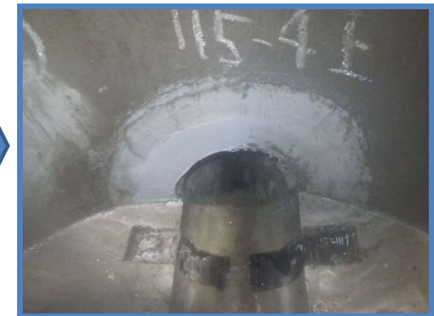
⑥設置完了
