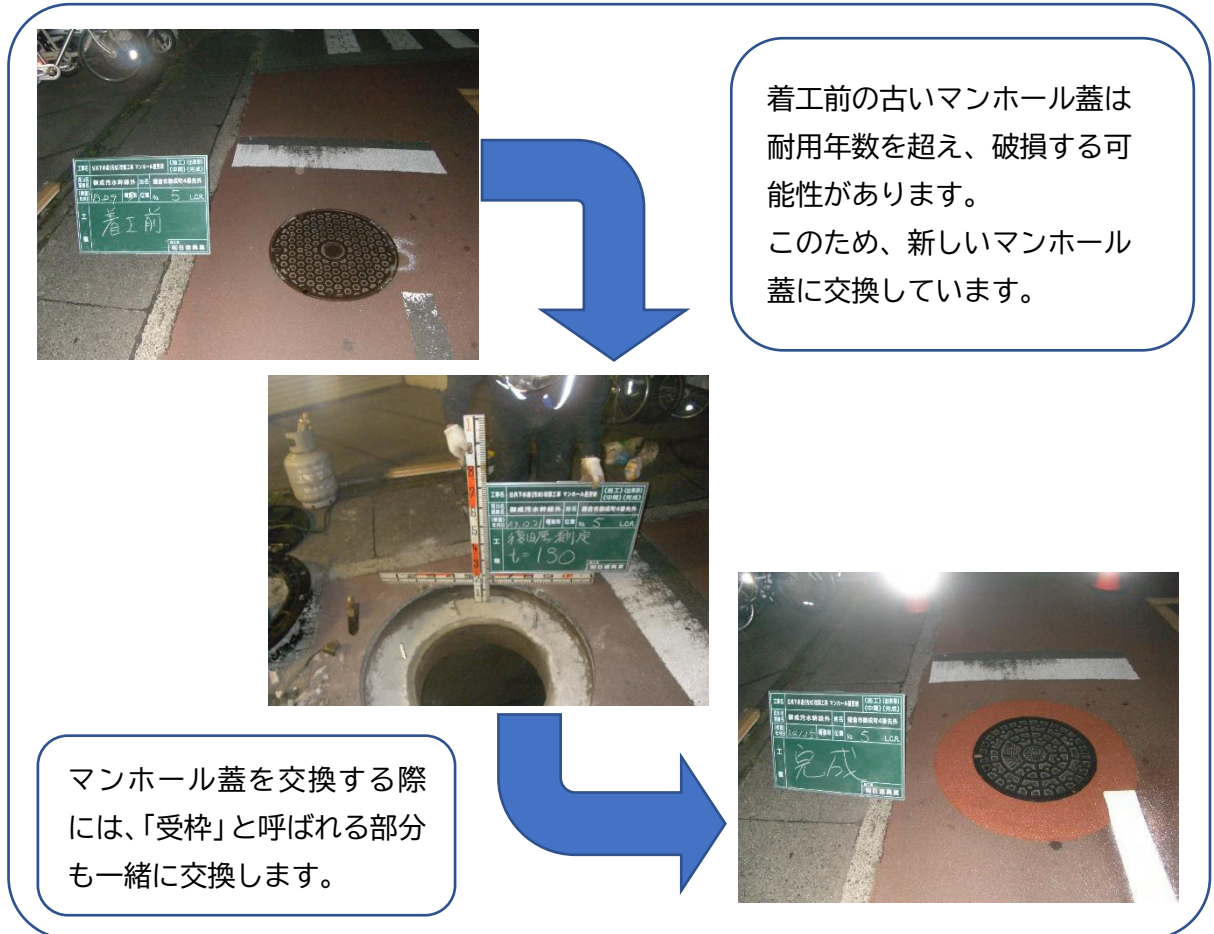
マンホール蓋・受枠の交換工事の様子
