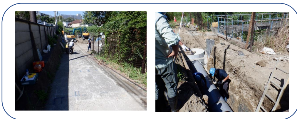
雨水施設への雨水流入管の工事の様子
