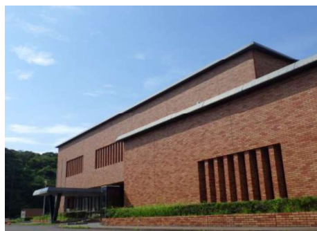
七里ガ浜浄化センター
