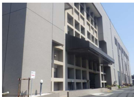
山崎浄化センター
