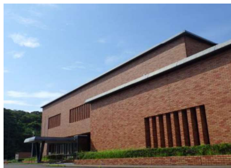
七里ガ浜浄化センター
