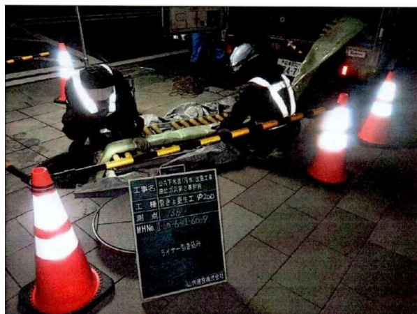
管更生施工状況
