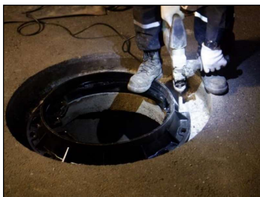
蓋交換施工状況
