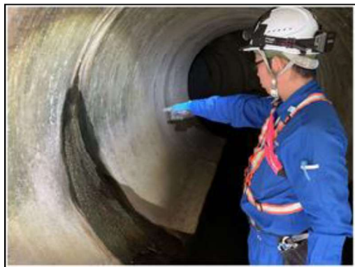
点検・調査の状況
