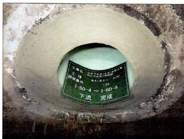
管更生施工完了
