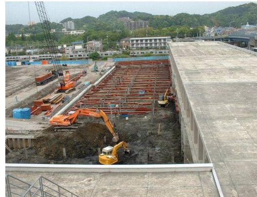
山崎水質浄化センター C系水処理棟増設工事
