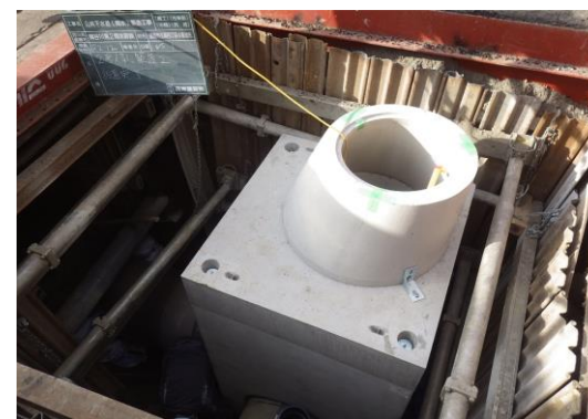
マンホール据付状況
