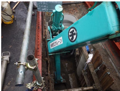
開削工法による掘削状況
