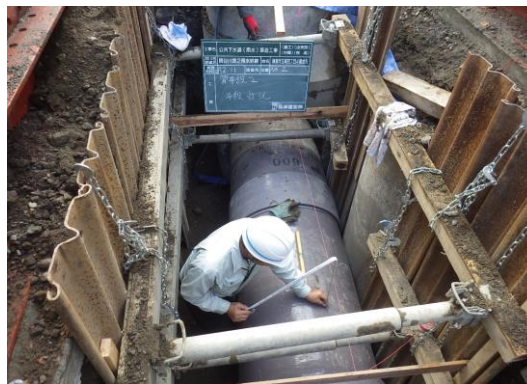
Φ800mm管布設状況
