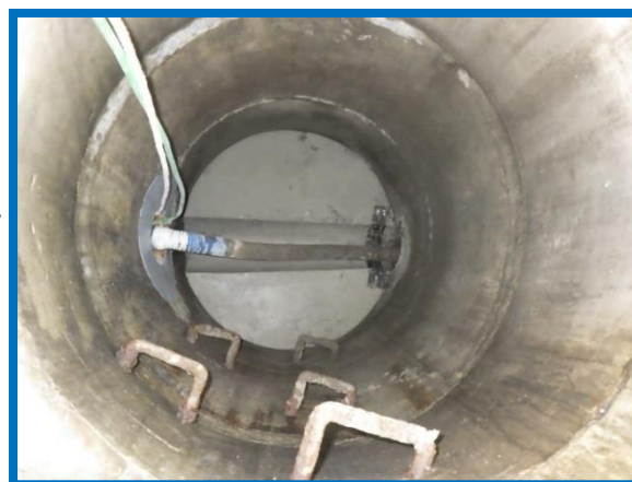
⑤インバート復旧状況
