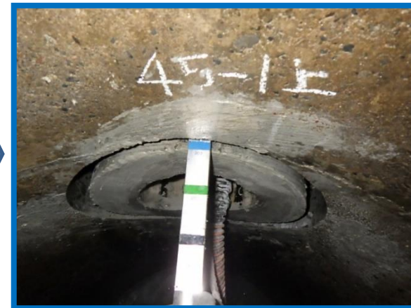
③切削状況確認
