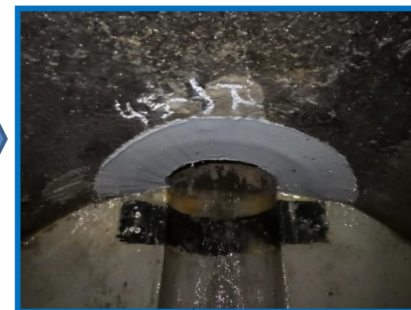
⑥設置完了
