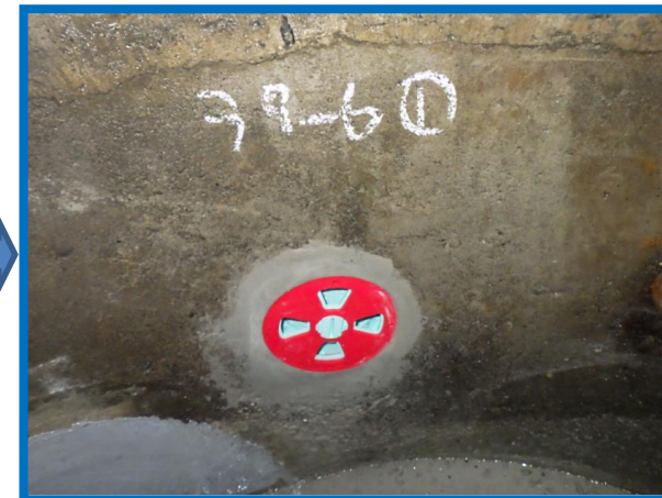
③設置完了 (消散弁設置状況)
