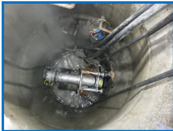
②管口切削状況
