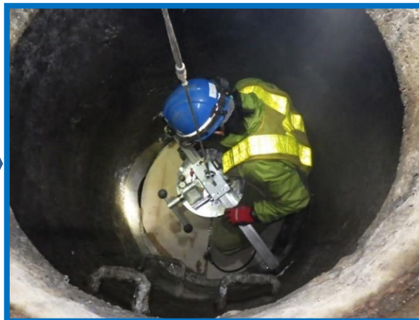
②削孔状況
