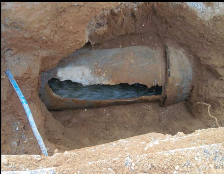
圧送管吐出し部付近の管の劣化状況(H22年七里ガ浜圧送管)
