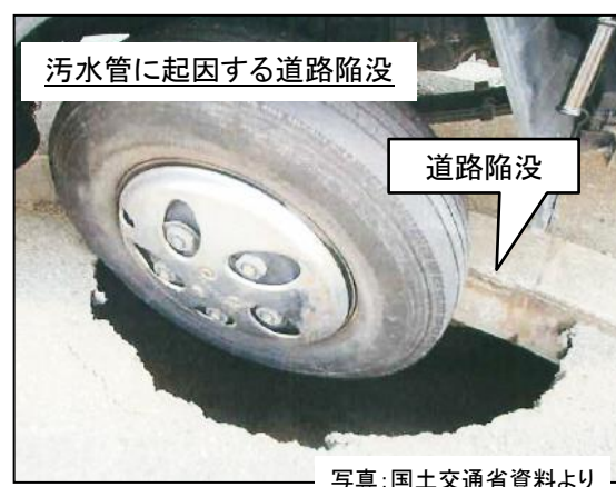
写真 污水管きよの破損状況
