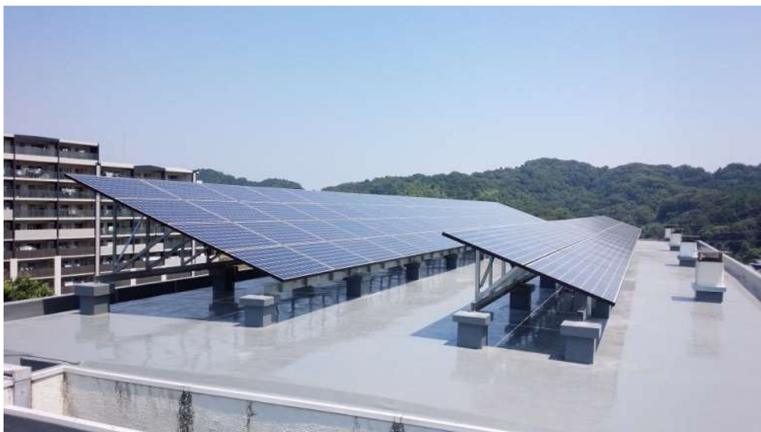
岩瀬中学校(屋上への太陽光パネル設置状況)
