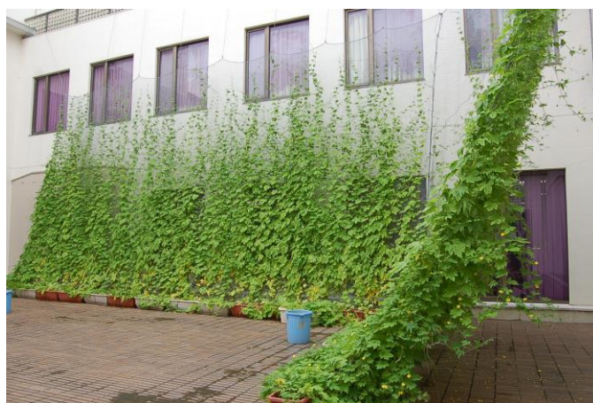
写真 市役所本庁舎の緑のカーテン実施状況
