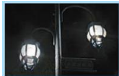
⇒ 交換後（LED ランプ 33W×2）
