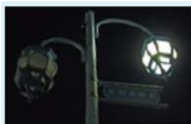
交換前（水銀ランプ 200W×2） ※左側は寿命によりランプ切れ
