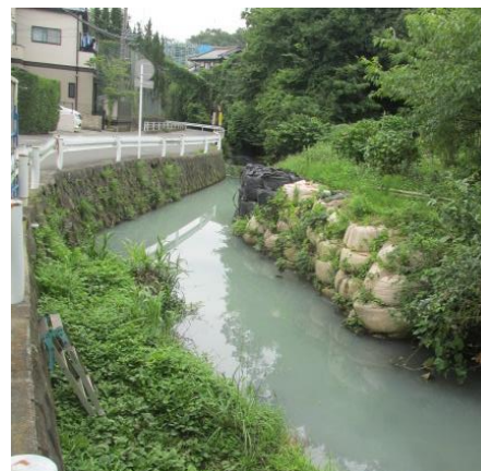
河川への白濁水の流出
