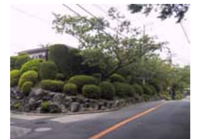
自然石の擁壁と上部の緑化
