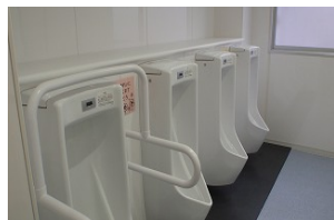
西鎌倉小学校 トイレ改修
