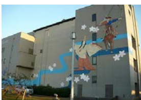
山崎浄化センター
