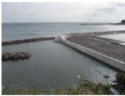
平成26年に完成した腰越漁港
