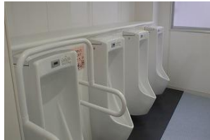
西鎌倉小学校 トイレ改修
