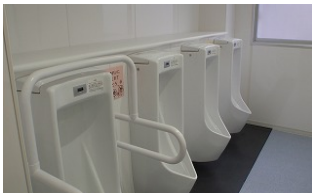
西鎌倉小学校 トイレ改修
