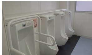
西鎌倉小学校 トイレ改修
