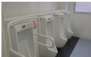
西鎌倉小学校 トイレ改修
