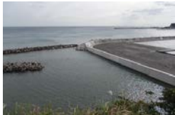
平成26年に完成した腰越漁港
