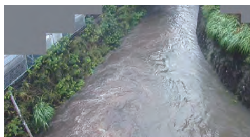
増水時 大雨により水位が上昇(7/2)
