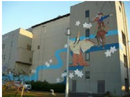
山崎浄化センター
