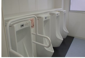
西鎌倉小学校 トイレ改修
