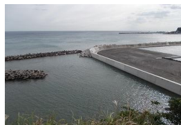
平成26年に完成した腰越漁港
