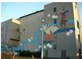
山崎浄化センター
