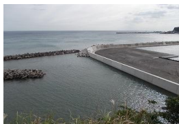
平成26年に完成した腰越漁港
