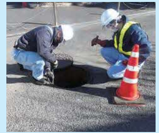
マンホールの定期点検
