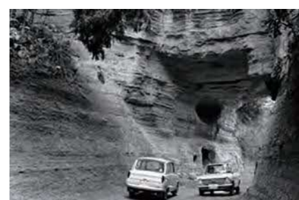
枳田堂口トンネル(昭和46年)
