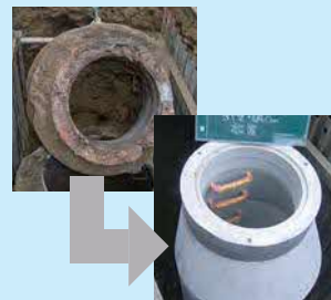
耐用年数が経過したマンホールを交換
