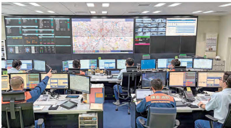
消防指令センターの様子
