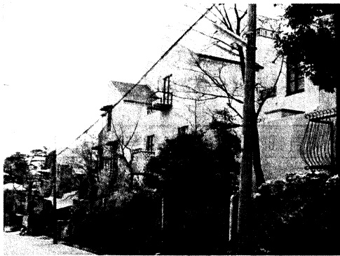
戸建て住宅地に融け込む、分節化（※）された壁面デザインの例。
