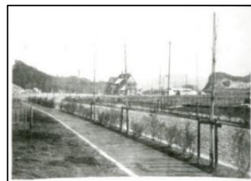
田園都市構想により整備された道路の様子 [鎌倉中央図書館所蔵]
