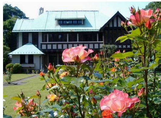
■旧華頂宮邸 建築物と緑の一体的な保全・活用を図ります。
