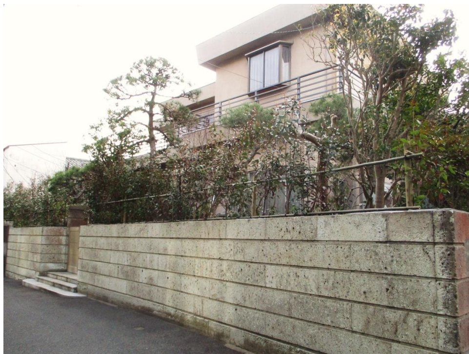
※ まち並みのみどりの奨励事業 施工例 (危険ブロック塀等を撤去し、生け垣を植栽しました)
