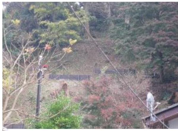
大径化し倒木の恐れのある樹木を伐採し、表土の流出を防止するための木柵を設置した状況(大町)
