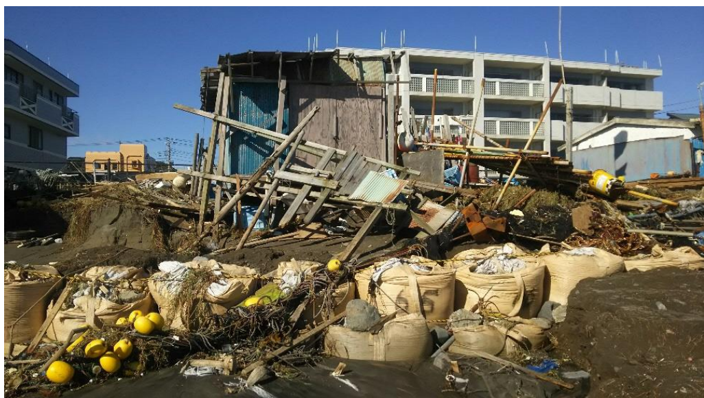
〔坂ノ下地区の漁具倉庫の被害状況〕
