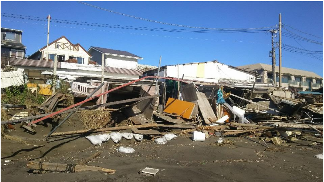
〔材木座地区の漁具倉庫の被害状況〕
