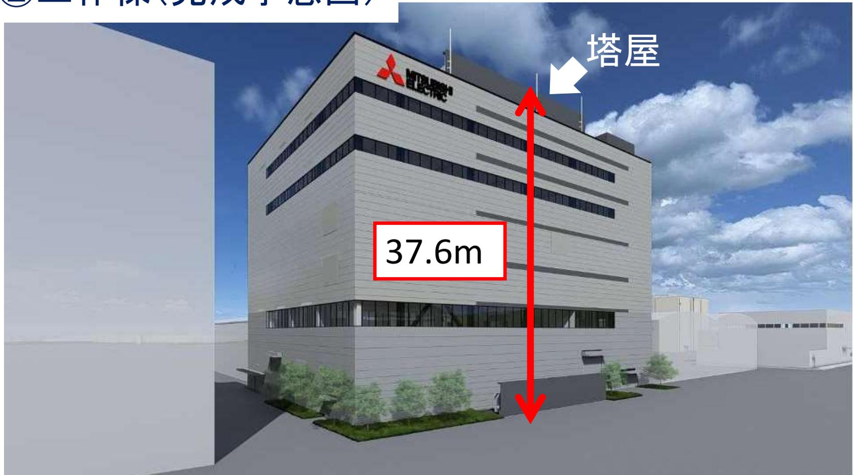
①大型製品の試験のため、約20mの吹抜け構造が必要であり、②機密性を確保し、設計～組立～試験をひとつの建物内で完結させるには、上層階に設計室等の配置が必要であるため、31mを超える高さとなる必要がある
