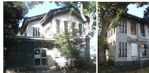
平成 30 年 (2018 年) 当初工事前の外観
